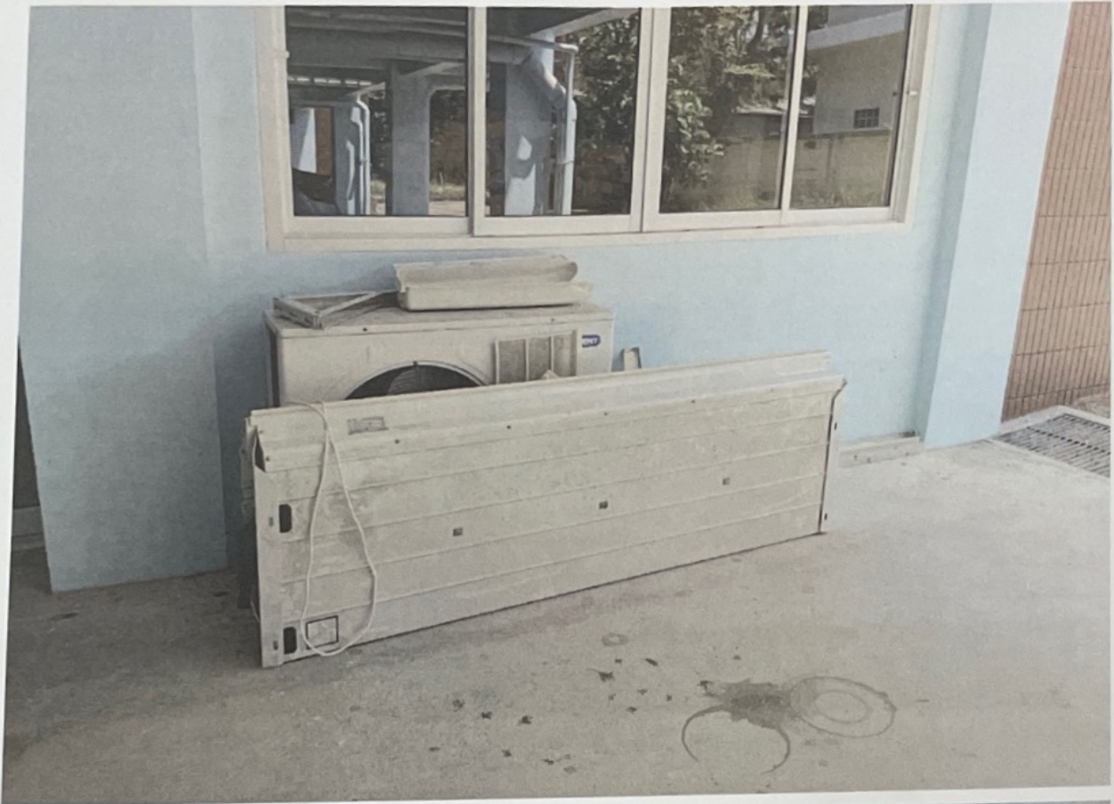
ครุภัณฑ์สำนักงานประเภทเครื่องปรับอากาศและพัดลมเพดาน จำนวน 17 รายการ
