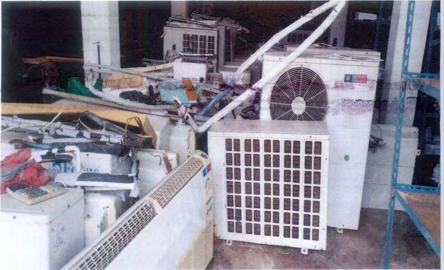
เครื่องปรับอากาศ เล็กใช้งาน (ครุภัณฑ์เสื่อมสภาพ) จำนวน ๔๐ เครื่อง
